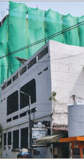
कानपुर में एक नए भवन के निर्माण का दृश्य।
